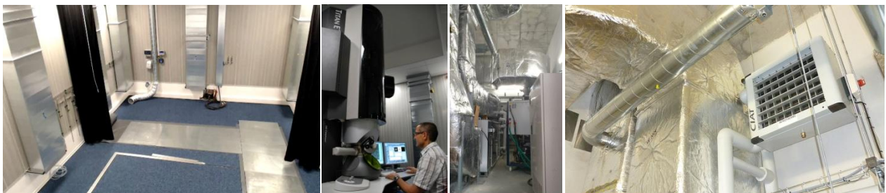
Pièce du microscope et local attenant abritant les éléments techniques (climatisation, centrale de traitement d'air, refroidisseur, et onduleur ; photos © CLYM)
