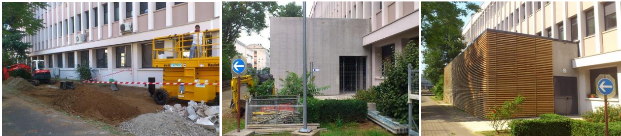
Le bâtiment du CLYM en cours de construction (vu de l'extérieur)
